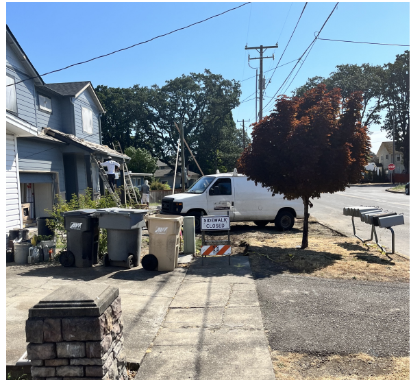
Fig. 12: Sidewalk Construction en Route
